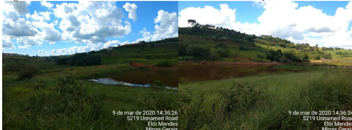
Figura 7 – Estrutura de barramento num trecho da extensão do Ribeirão da Onça, Elói Mendes, MG. 2020
