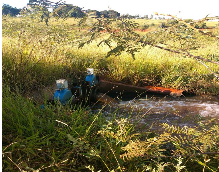
Figura 16 – Medidores de vazão na barragem do ribeirão da Onça
