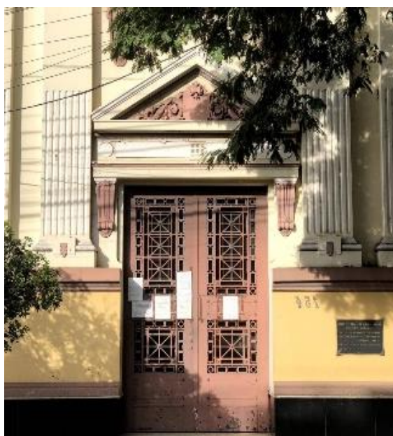
Figura 19 - Prédio na Avenida Getúlio Vargas, no centro da cidade, que sediou a primeira agência do Banco do Brasil do estado de Minas Gerais, sendo a 12ª agência do país. Inaugurado em maio de 1929
