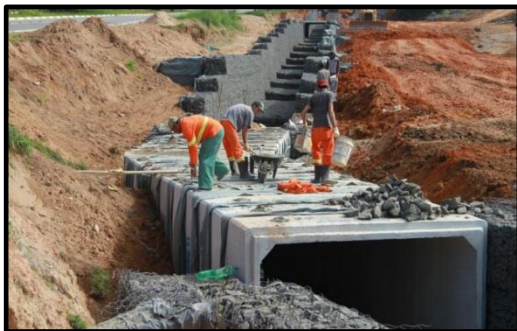
Canalização/retificação de curso d'água
