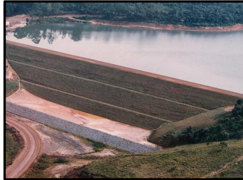
Barragem de contenção de rejeitos de mineração
