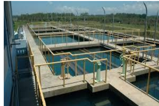
Estação de Tratamento de Água
