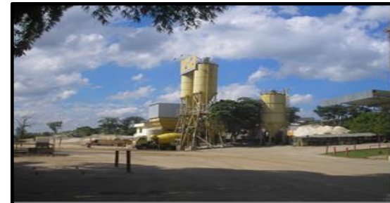
Usina de Concreto
