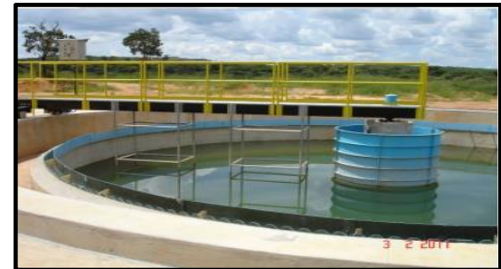
Estação de Tratamento de Esgoto
